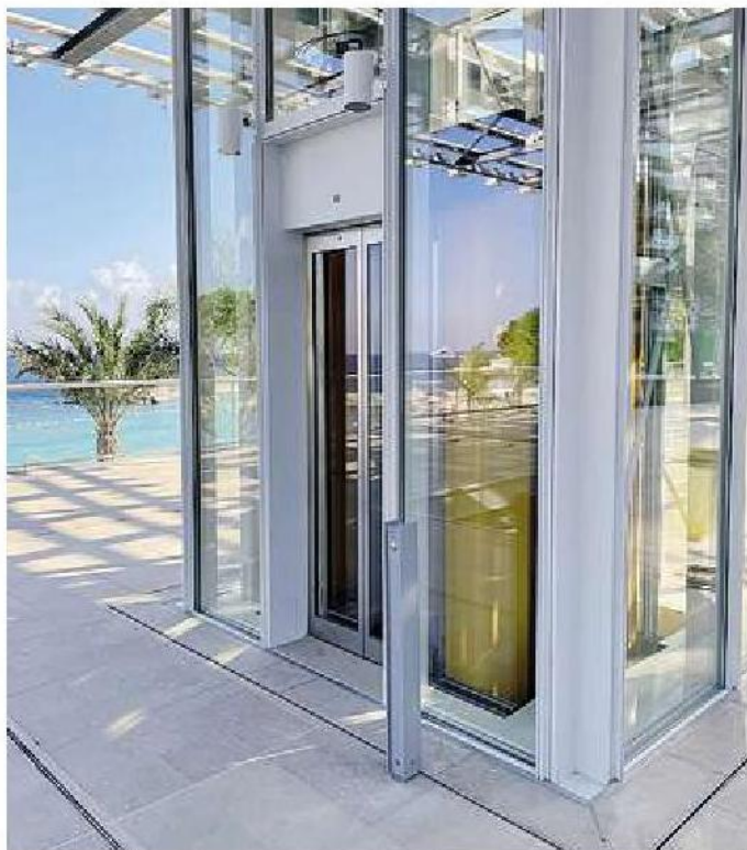
Uno degli ascensori panoramici realizzati da Maspero Elevatori
