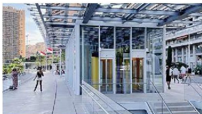
Un altro impianto per l'intervento nel Principato di Monaco
