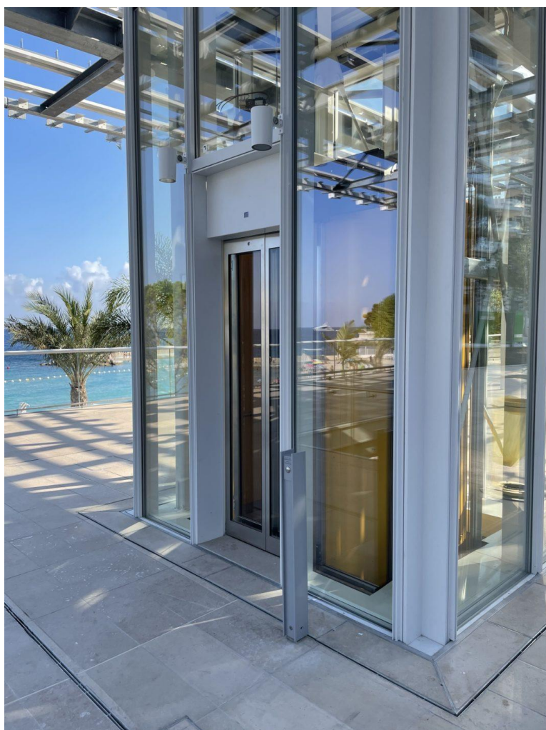
Uno degli ascensori realizzati da Maspero Elevatori nella spiaggia del Larvotto
