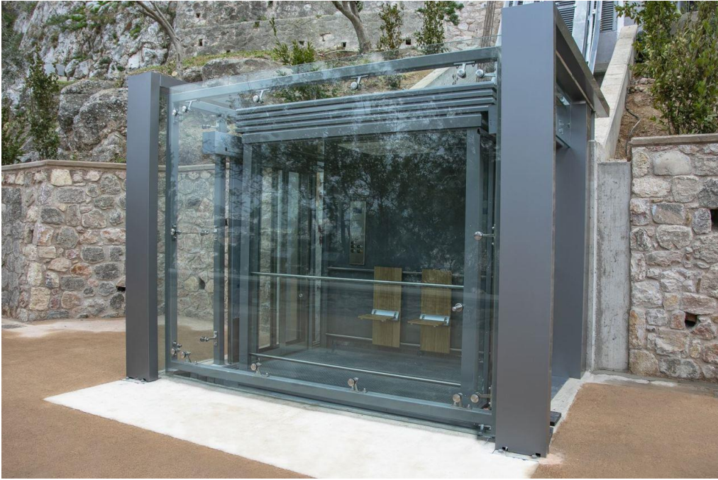
La cabina dell'ascensore
